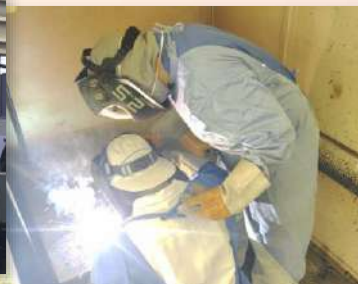
電気溶接職種
