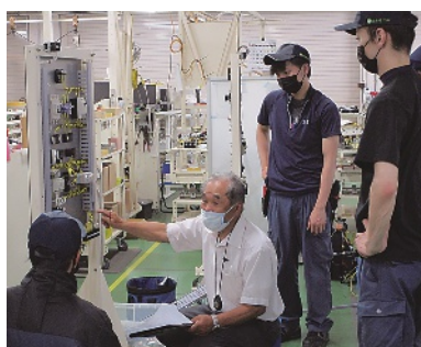
配電盤・制御盤組立て
